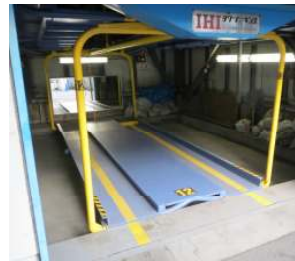
立体駐車場ハンガー補強
