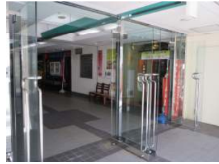
新通路テンパードアガラス交換
