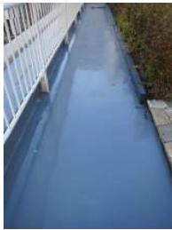
本館・新館屋上防水
